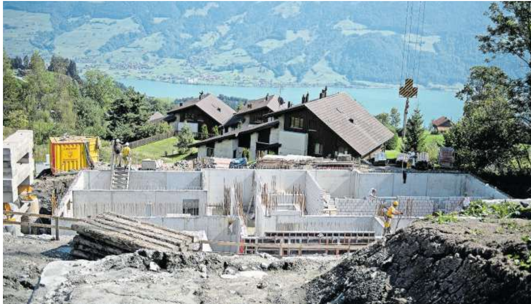
Baustelle auf der Stockenmatt mit Blick auf den Sarnersee. Bild: Corinne Glanzmann (Stalden, 4. September 2018)
