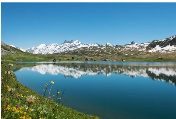
Stausee des Elektrizitätswerks Obwalden auf der Melchsee-Frutt (Melchsee)
