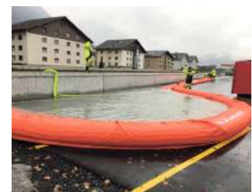
480 Meter lange Schutzdämme im Einsatz.
