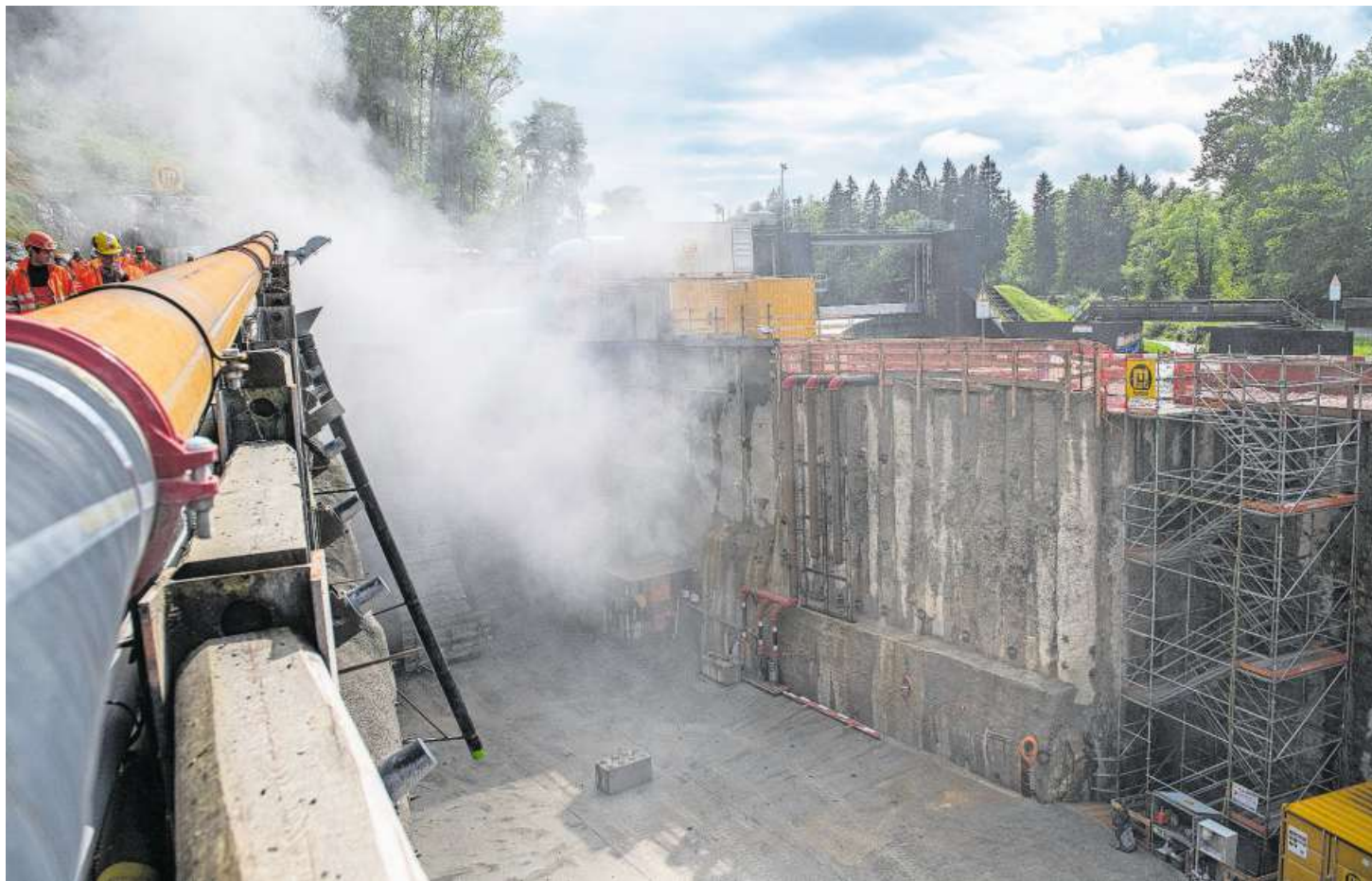
Der Rauch der ersten Sprengung für den Hochwasserstollen verzieht sich aus der Baugrube.
