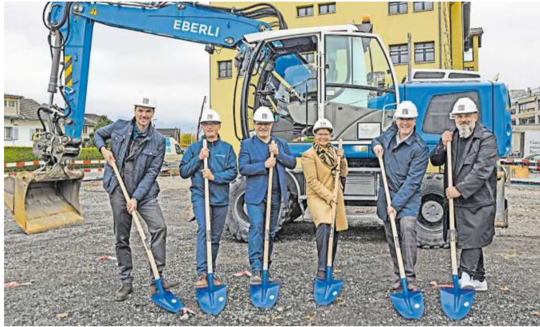
Spatenstich zum neuen Bauprojekt in Sarnen Nord.
