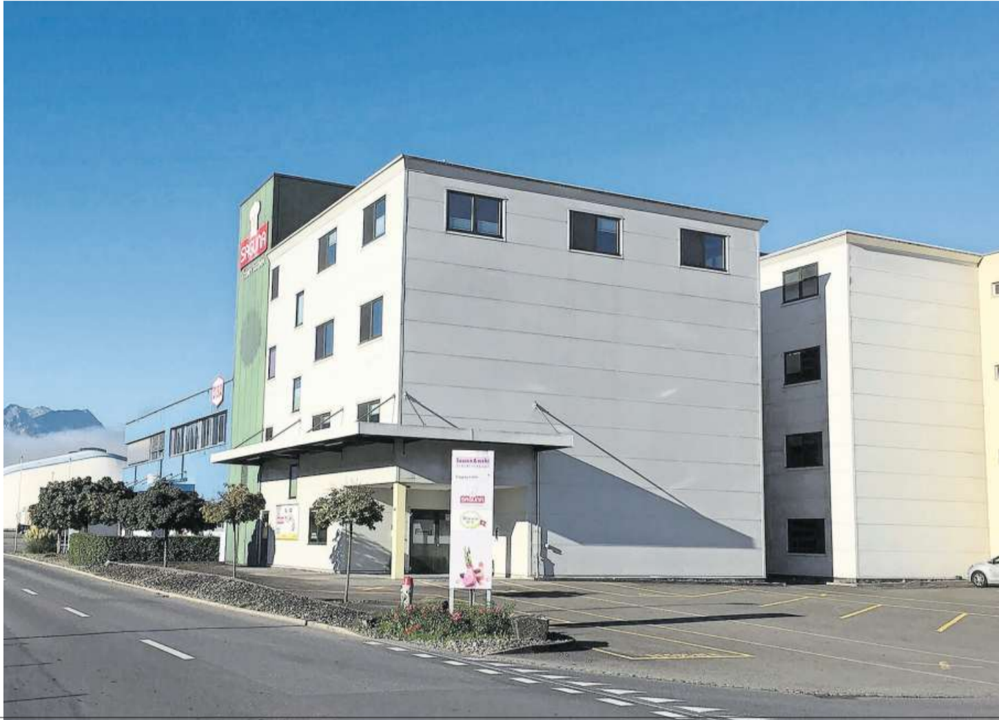
Das Obwaldner Impf- und Testzentrum an der Kägiswilerstrasse 35 in Sarnen.
