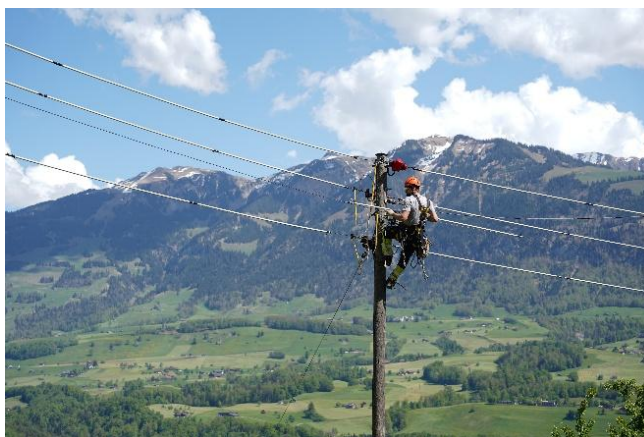
Ein EWO Netzelektriker beim Unterhalt von Freileitungen.
